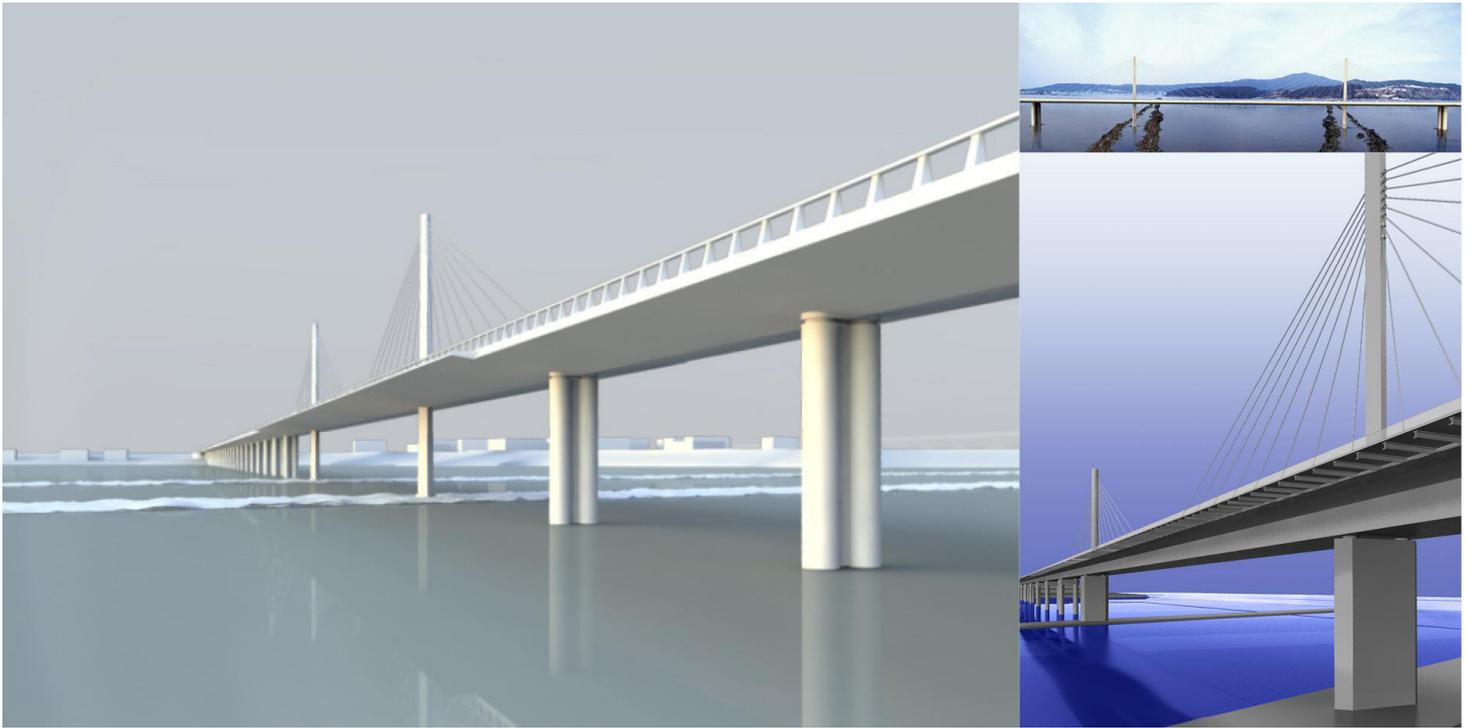
Se trata de un viaducto de longitud total igual a 1470 m, divididos en 46 vanos de las siguientes luces: 21.00 + 27 x 30.00 + 48.00 + 102.00 + 48.00 + 14 x 30.00 + 21.00.
